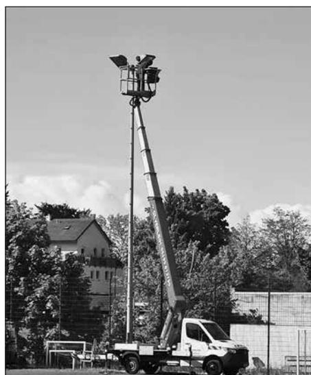
In der vergangenen Woche wurde endlich ein mit Spannung erwartetes Projekt finalisiert. Durch die Firma „Kandem Leuchten GmbH“ konnten die alten Strahler auf dem Bretniger Sportplatz in den verdienten Ruhestand geschickt und gleichzeitig die neuen LED-Flutlichtstrahler installiert werden. Nachdem diese binnen eines Tages angebracht wurden, stand mit Beginn der Dämmerung noch der Funktionstest an. Zu
