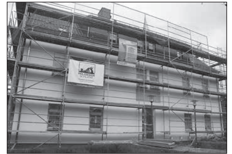
Seit Oktober 2023 saniert die Stadt die einstige Schule am Krohnenberg im Ortsteil Hauswalde.
