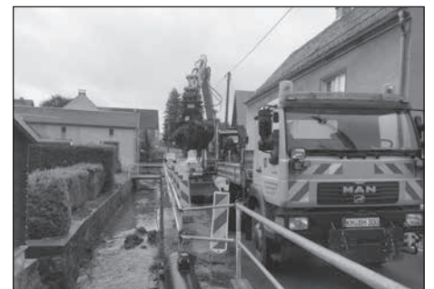
400 Tonnen Schlamm und Pflanzen holen die Mitarbeiter des Technischen Dienstes aus der Röder und dem Hauswalder Bach heraus.
