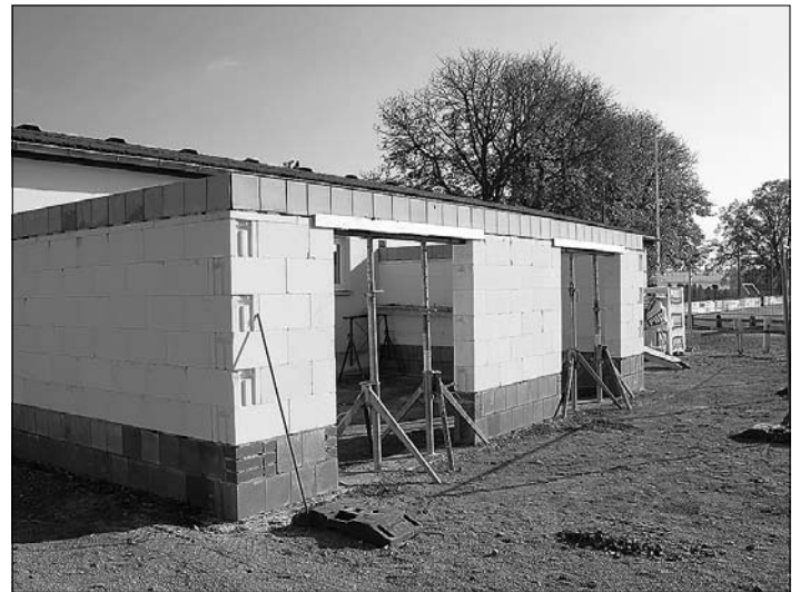
Rohbau in Massivbauweise des Geräteraumes im Oktober 2014
