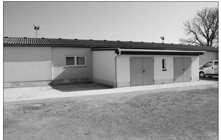
Fertigstellung des Geräteraumes und Übergabe an die Sektion Leichtathletik der SG Großröhrsdorf im März 2015
