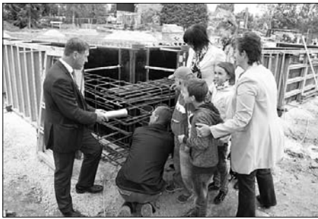
Am 8. September erfolgt die Grundsteinlegung für die neue Grundschule im Ortsteil Bretnig.
