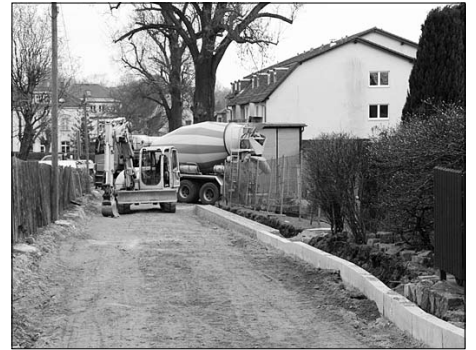
Im Frühjahr konnte der Straßenbau in und um das Lehngrut zum Abschluss gebracht werden.
