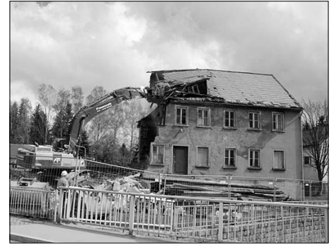
Abriss der alten Schule am Klinkenplatz im Ortsteil Bretnig
