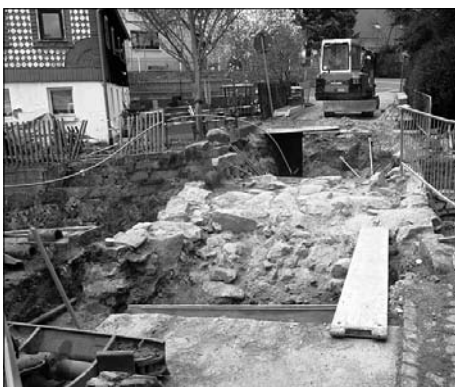
Die Röderbrücke an der Bergstraße wird saniert.
