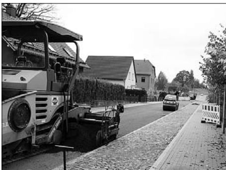
Die Brauereistraße zwischen der Großmannstraße und der Bahnhofstraße wird erneuert.
