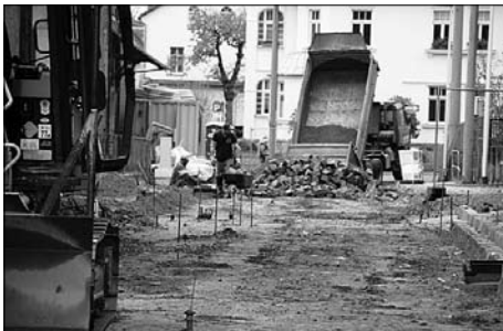
Ein Teil der Johann-Sebastian-Bach-Straße wird grundhaft ausgebaut.
