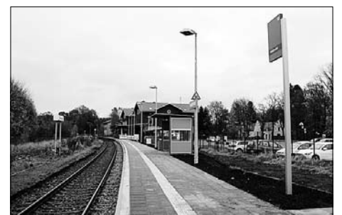
Die Deutsche Bahn baut den Großröhrsdorfer Bahnsteig aus.
