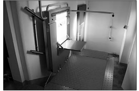
Ein Treppenlift ermöglicht nun den barrierefreien Zugang zum Rathaus.
