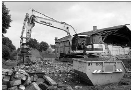
Ziegelbau im Lehngut wird abgerissen.
