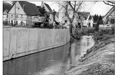
Erneuerung der Stützwände an der Großen Röder in der Niederstadt
