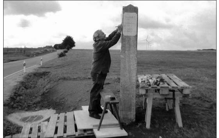
Restaurierung der Wegesäule in Kleinröhrsdorf durch den Restaurator Mathias Hennig (Foto: E. Miersch)
