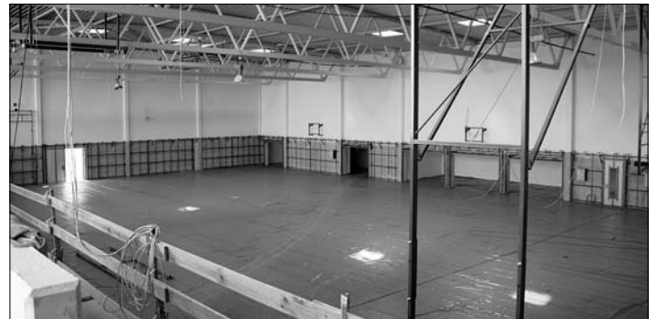
Blick in die neue Drei-Feld-Sporthalle
