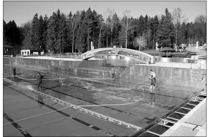
Die Mitarbeiter des Massenei-Bades nutzen Ende März die schönen Sonnenstunden für die Komplettreinigung der Edelstahlbecken des Massenei-Bades - hier im Speziellen für die Reinigung der Frischwasserzuleitungen, die sich am Boden der Becken befinden.
