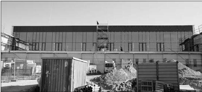
Die Gebäudehülle der Sporthalle ist schon geschlossen. In den vergangenen Tagen wurden die Fenster eingesetzt und fleißig die Fassade komplettiert.
