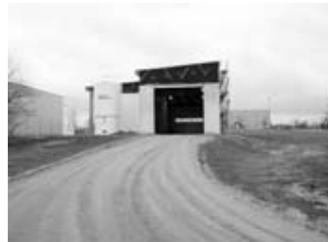
Eine neue Tankwagenreinigungsanlage entsteht im Gewerbegebiet.
