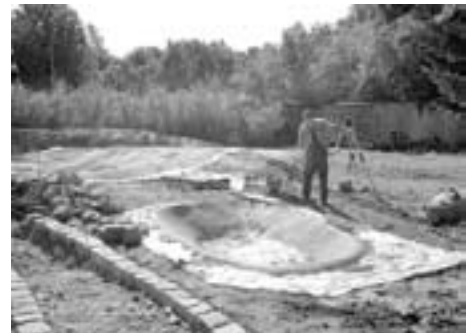
Neubau des Spielplatzes in Hauswalde
