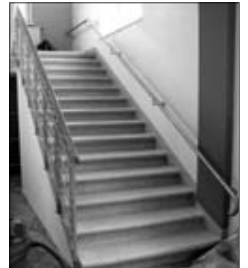
Auch das Geländer erhielt einen neuen Farbstrich
