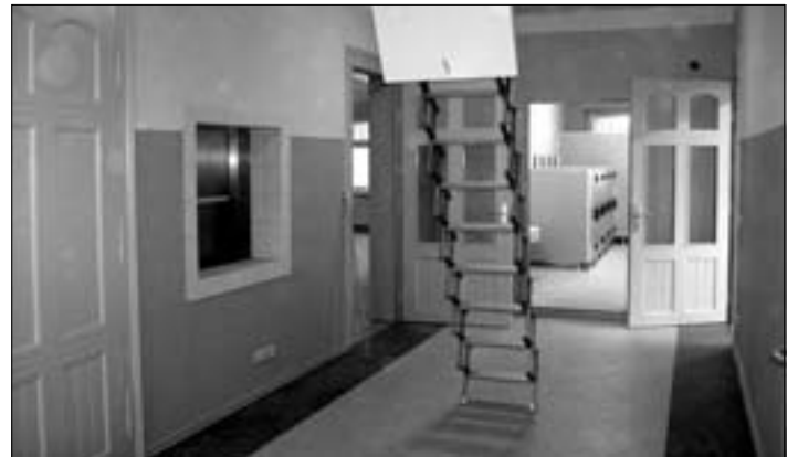
Ein Aufzug in der Wand erleichtert den Essenstransport
