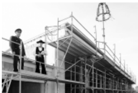
Am 11.10.2007 erfolgte das Setzen der Richtkrone am neuen Feuerwehrgerätehaus & Richtfest.
