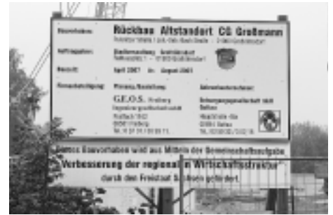
Abschluss der Rückbaumaßnahmen im August 07 und Übergabe des Geländes an die Sunfilm AG.
