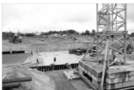
Zügige Baufortschritte bei der SunFilm AG - Bauphase 5 Wochen nach dem 1. Spatenstich
