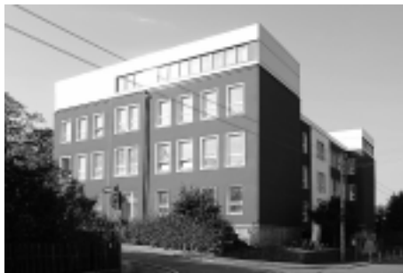
August 07: Der Innenausbau läuft auf Hochtouren. Im Februar 08 geht die Schule wieder in Betrieb
