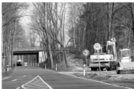
Im April beginnt der Bau eines Radweges nach Pulsnitz - Fertigstellung Anfang Juli
