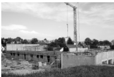
Baufortschritt am Feuerwehrgerätehaus im Aug.07
