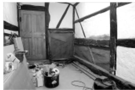
Denkmalsgerechte Baumaßnahmen im Heimatmuseum durch den Heimatverein
