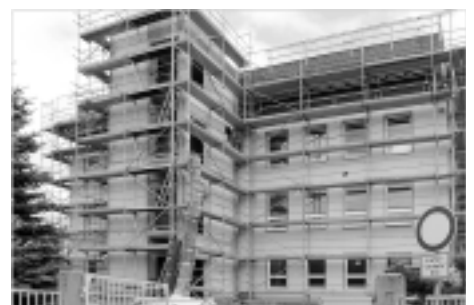
Fortführung der Aus- und Umbaumaßnahmen an der Praßersschule
