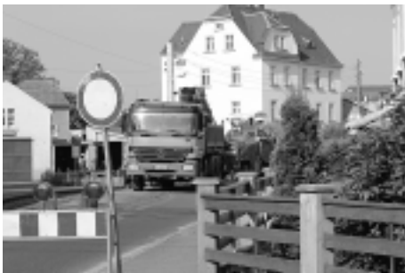
Straßenbaumaßnahmen einschließlich Kanalbau in der Niederstadt
