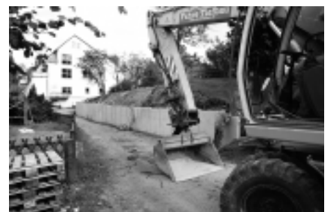
Zur Rathausvorplatzsanierung gehörend: Errichten einer Stützmauer zum Eingangsbereich Haus-Nr.2
